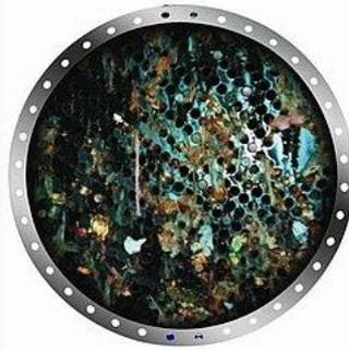
Um trocador de calor em uma usina de energia a vapor contaminada com macro-incrustação.
