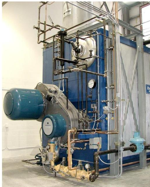
O aquecimento dos tubos e da água existente dentro destes tubos é feito com o calor gerado pela queima do combustível com o ar de combustão no(s) queimador(es); este calor é transferido pelos gases da combustão existentes fora dos tubos.
