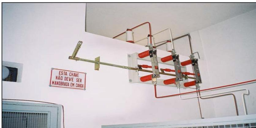
Chave seccionadora típica de uma subestação industrial interna.
