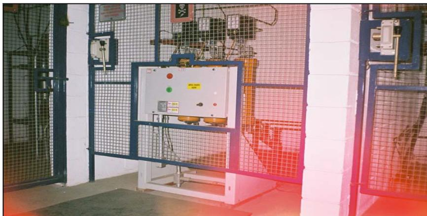
Equipamento disjuntor instalado numa subestação industrial interna
