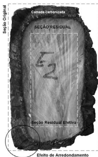
FIGURA 47 - Seção de uma viga de Eucalyptus grandis exposta a curva padronizada
