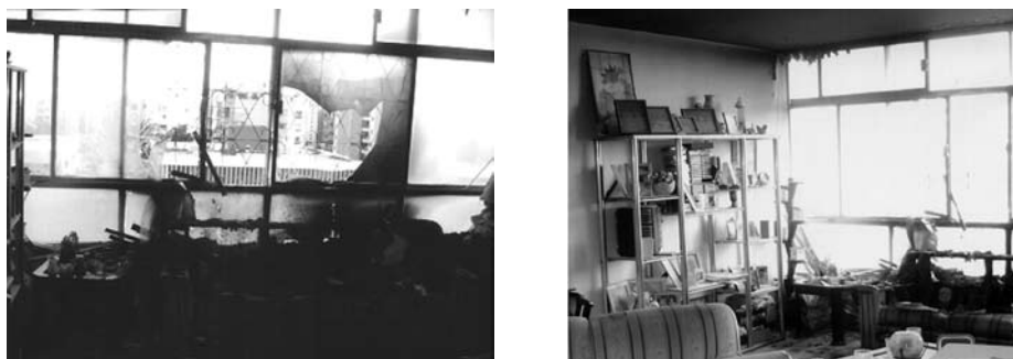
FIGURA 2 - Incêndio em residência causado por cigarro atirado pela janela de um pavimento superior ao da residência sinistrada
