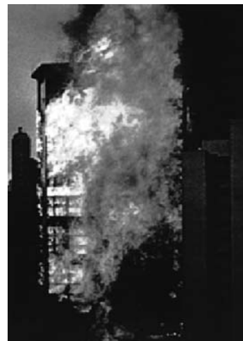
Foto do incêndio do Edifício Andraus
