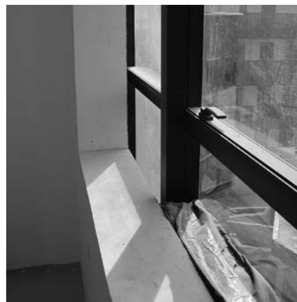
FIGURA 9: Proteção do espaço entre a estrutura da edificação e a pele de vidro
