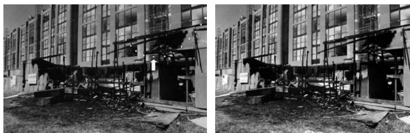
FIGURA 7 - Incêndio em canteiro de obras de edifício da Asa Norte, Brasília, causado pela ação de uma desconexão da mangueira de gás liquefeito de petróleo (GLP) do fogareiro quando em utilização
