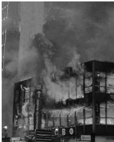
Foto do incêndio no Edifício Grande Avenida
