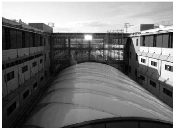
FIGURA 15: Vista aérea da cobertura de ETFE
