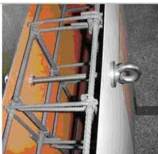
instalação dentro de viga de concreto
