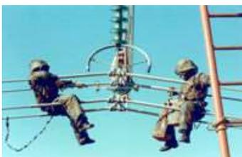
Nas linhas de transmissão aéreas são usados, geralmente, cabos nus de alumínio com alma de aço, que ficam suspensos em torres metálicas através de isoladores. Nas linhas de transmissão subterrâneas são usados cabos isolados, como os cabos refrigerados a óleo fluido (OF) ou os cabos isolados com borracha etileno-propileno (EPR).
