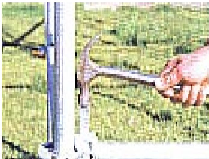
As 8 posições da junta permitem formar qualquer ângulo, possibilitando grande flexibilidade no sistema de estrutura, andaimes ou qualquer outra montagem.
